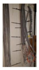
Instalaciones sanitarias. Fijación de pequeñas tuberías de agua caliente y fría.
