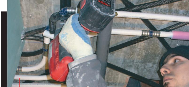
**1 Controle** que su prensado se re realiza correctamente realizado gracias a la indicación del led en fin de ciclo.
